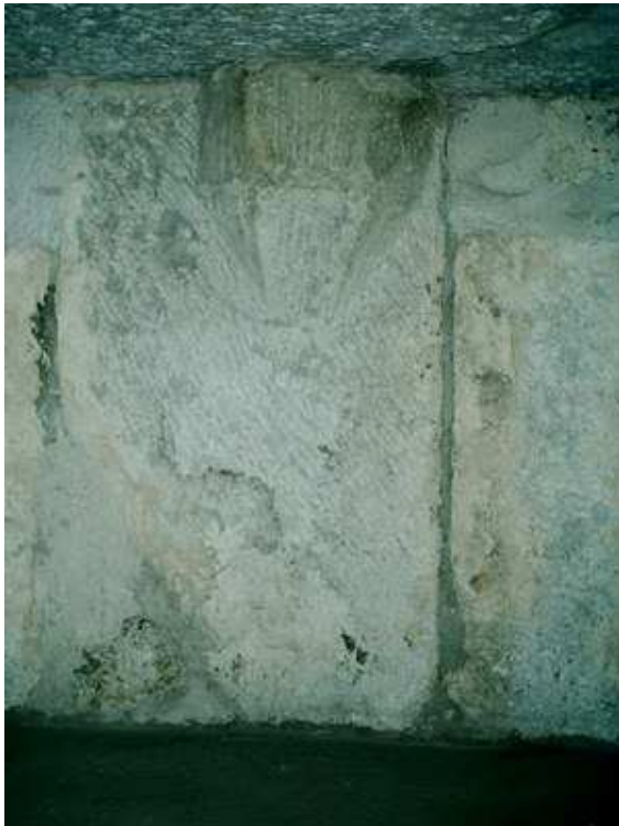
Bild 2: das Innere eines historischen Kastenaltars von ca. 1250; unten ist zu sehen der Estrich, oben die Altarplatte, direkt darunter das schön gehauene und eigentlich nicht sichtbare Sepulcrum
