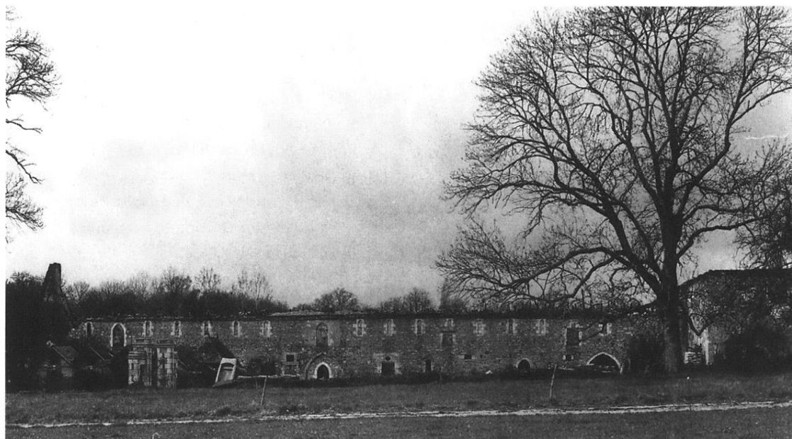
Fig. 41 Vue de la grange peu après l'incendie du 15 mars 1993. (Ph. D. Bontemps Cl. M. H.)
