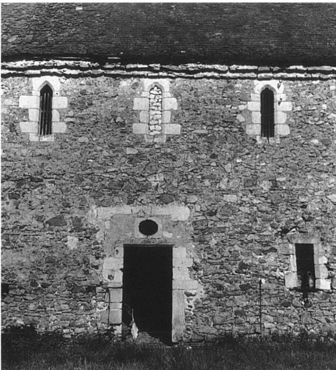
Fig. 13 Façade orientale-Quatrième porte. (Ph. D. Bontemps Cl. M. H.)
