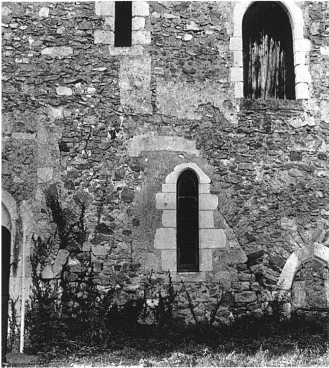
Fig. 17 Façade orientale. Traces de porte au sud. (Ph. D. Bontemps Cl. M. H.)
