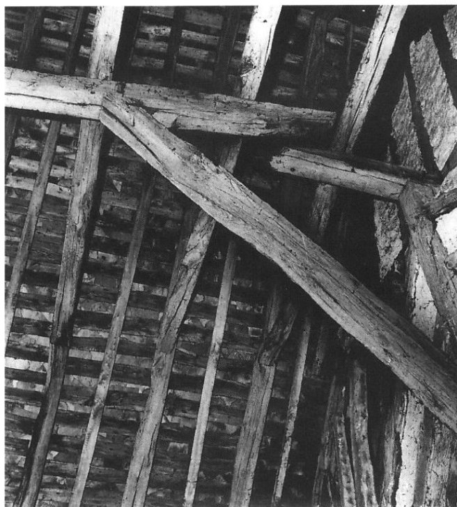
Fig. 38 Charpente- Sous-faîtage entre les fermes 56 et 57. (Ph. D. Bontemps Cl. M. H.)
