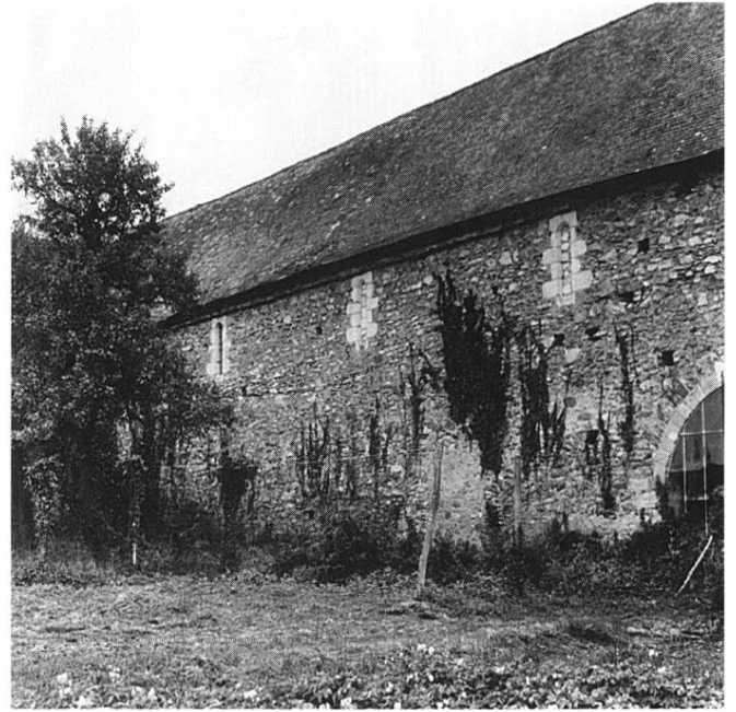
Fig. 4 Façade occidentale. Baies. (Ph. D. Bontemps Cl. M. H.)
