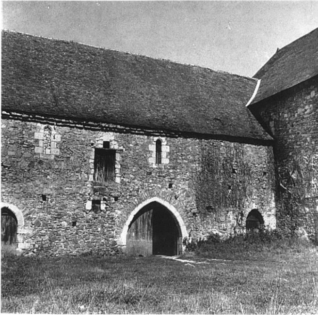
Fig. 3 Façade orientale. Extrémité nord. (Ph. D. Bontemps Cl. M. H.)
