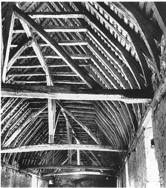
Fig. 6 Vue de la charpente vers le nord. (Ph. D. Bontemps Cl. M. H.)
