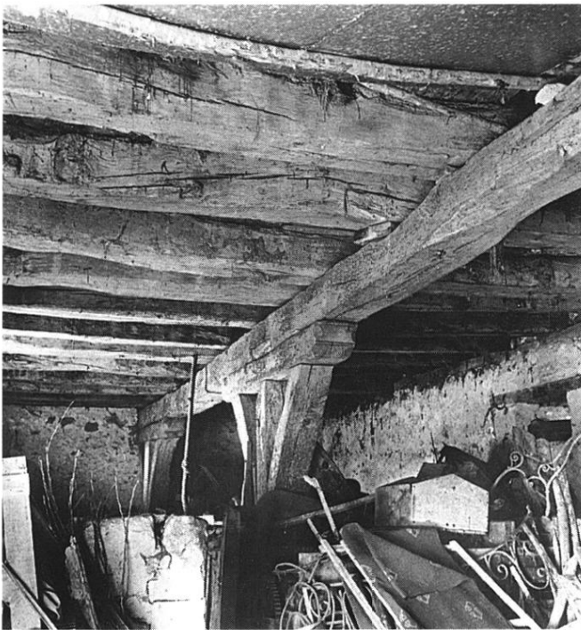
Fig. 31 Rez-de-chaussée au nord- Grande salle- Plancher et cours de poutres vue vers le sud. (Ph. D. Bontemps Cl. M. H.)
