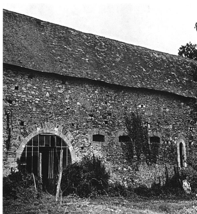
Fig. 20 Façade occidentale - Porte du passage transversal. (Ph. D. Bontemps Cl. M. H.)
