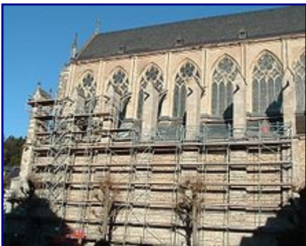
Baugerüst am Altenberger Dom im Januar 2005.
