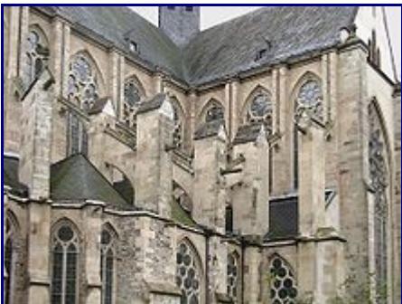
Altenberger Dom, Strebewerk an der Vierung.
